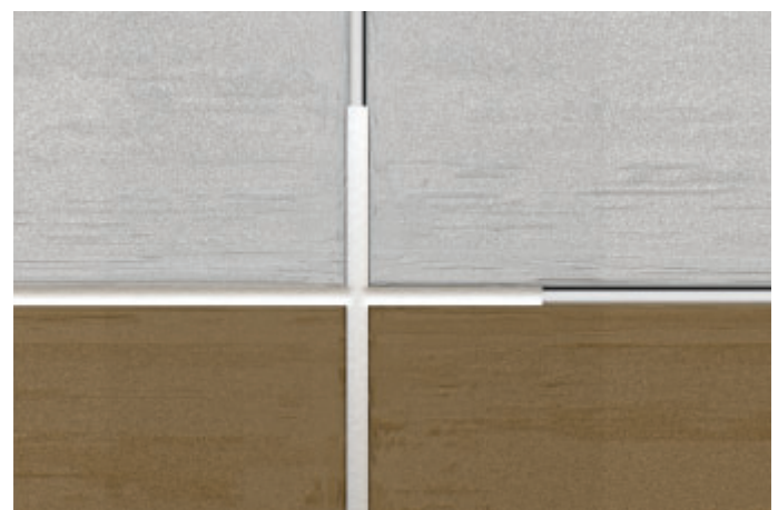
detail růžku zaspárovaný silikonem
